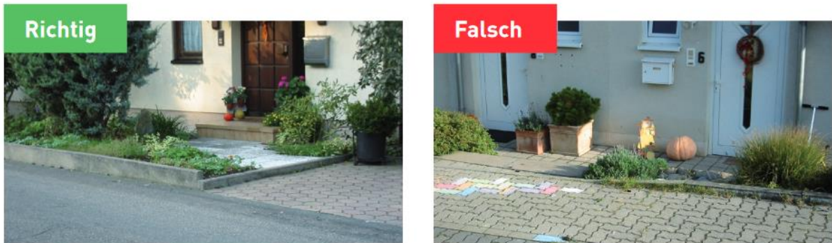
Abbildung 35 Schutz ebenerdiger Gebäudezugänge [9]
