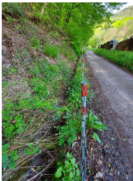
Abbildung 13 Dimbach, Graben südlich der Ortslage vor Einleitung in die MW- Kanalisation
