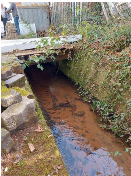
Abbildung 14 Hauenstein, Queich stark verbaut innerhalb der Ortslage
