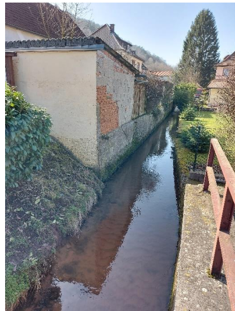
Abbildung 23 Wilgartswiesen, Queich mit starkem Uferverbau
