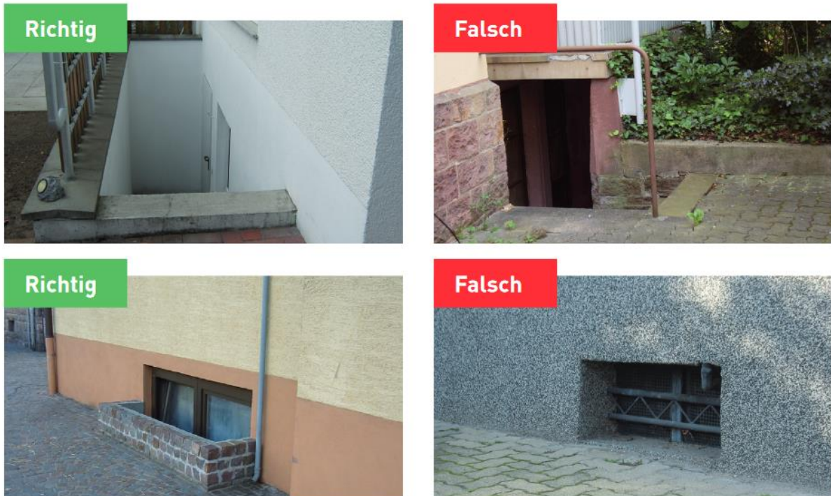
Abbildung 33 Schutz tiefliegender Gebäudezugänge [9]
